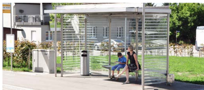
Möhlin, abri d'arrêt de bus sur la ligne 88 avec verre de protection des oiseaux
