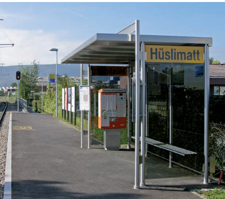
Shelter à la ligne BLT n°10 à Oberwil (BL) équipé de verre fumé
