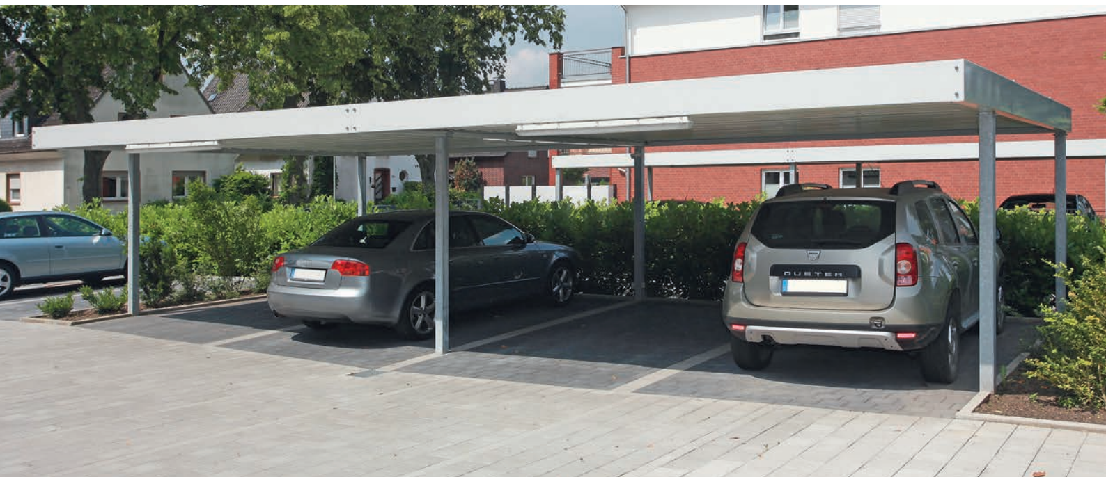
Stationnement sans peine possible pour jusqu'à 8 voitures grâce aux étais avant du toit en retrait
