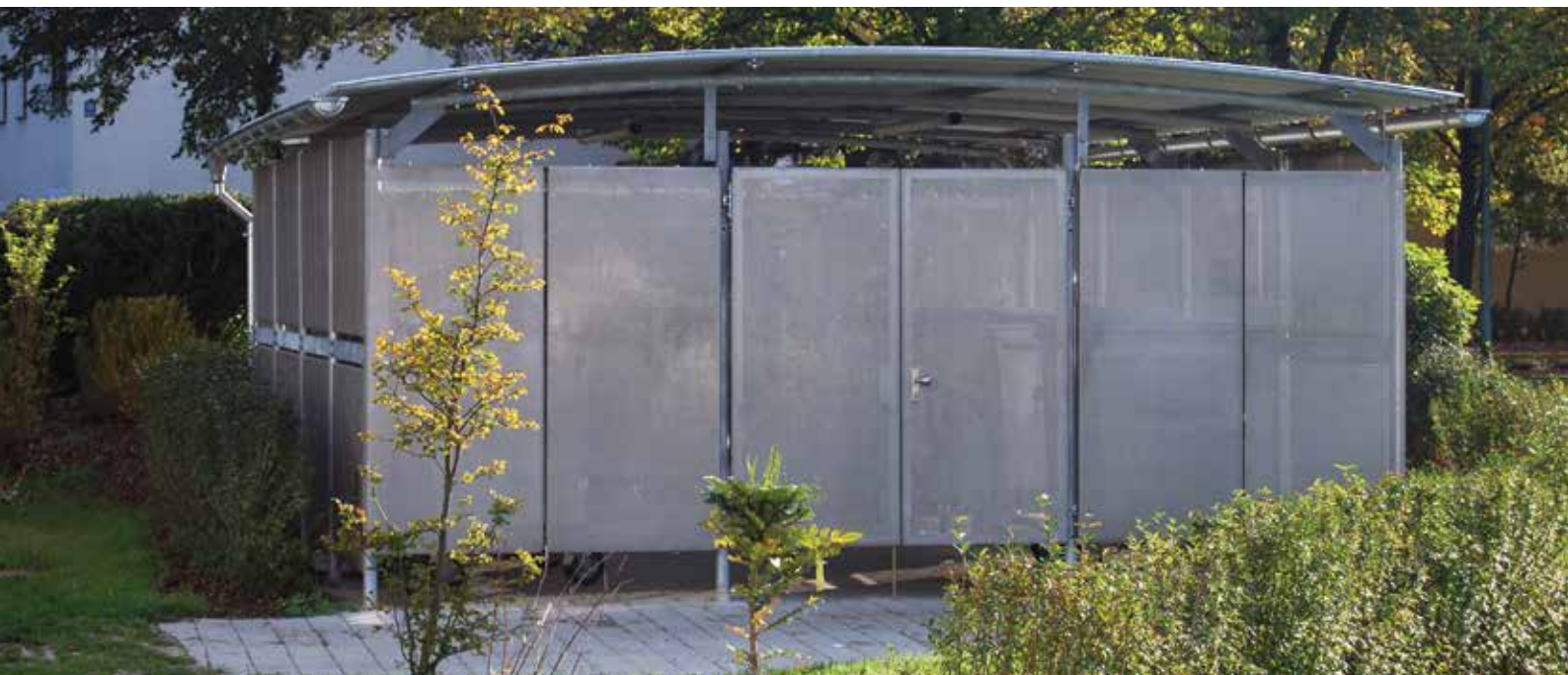
Parois et porte en tôle d'acier percée. Toiture en profilés de tôles d'acier
