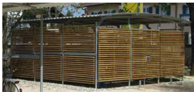
Parois et porte en lamelles de bois. Toiture en plaques de tôles d'acier
