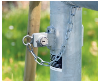
Gehäuse angeschweisst für den Einbau eines Schliesszylinders
