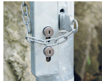
Gehäuse angeschweisst für den Einbau von zwei Schliesszylindern
