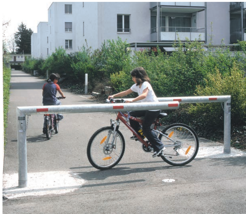
Bildung einer Schikane für den Durchlass von Personen
