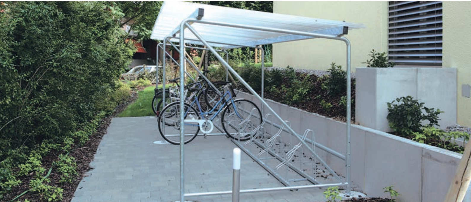
Filigrane Konstruktion mit lichtdurchlässigem Dach
