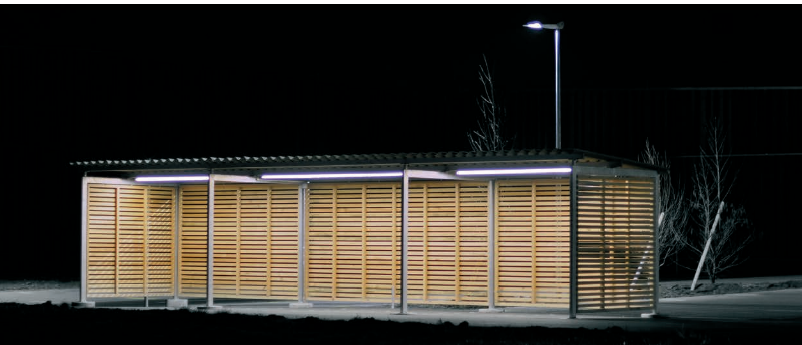
Das effiziente Velopa LED-Lichtband erzeugt eine warmweisse, angenehme Beleuchtung. Das Licht wird relativ gleichmässig verteilt und blendet nicht
