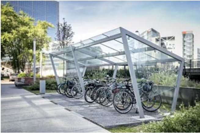
” *Diese elegante Überdachung für Fahrräder in kompromissloser dynamischer Form kombiniert feine Glaselemente in Edelstahlhalterungen mit verzinktem Stahl.*
