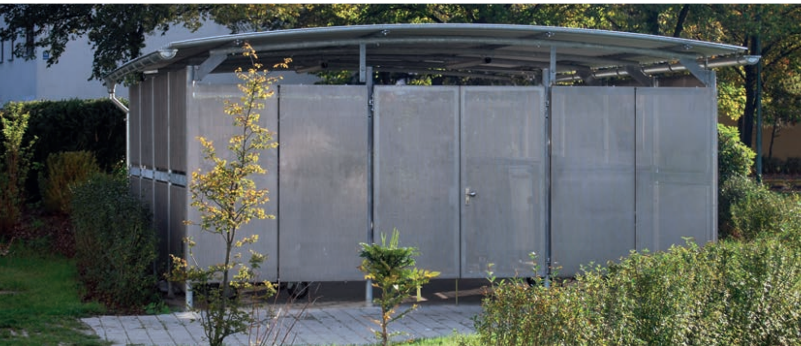
Exklusives Einstellhaus, Umwandung und Türe aus Lochblech, Dach Stahl-Profilblech
