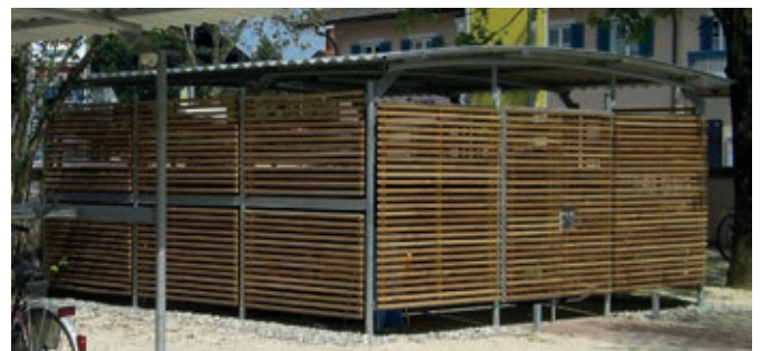
Umwandung und Türe aus Holzlamellen, Dach Stahl-Profilblech
