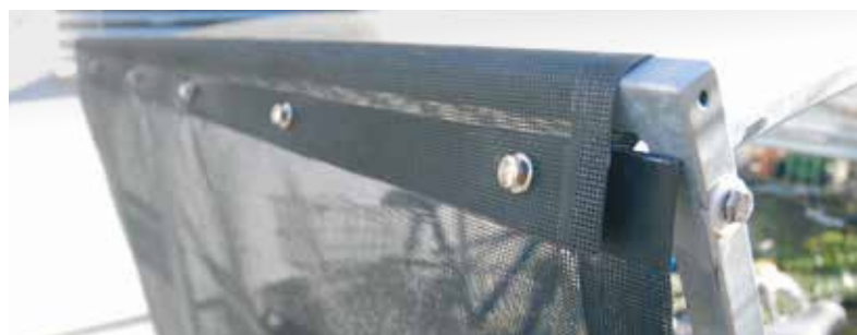
Bâche de protection « Filet » installée
