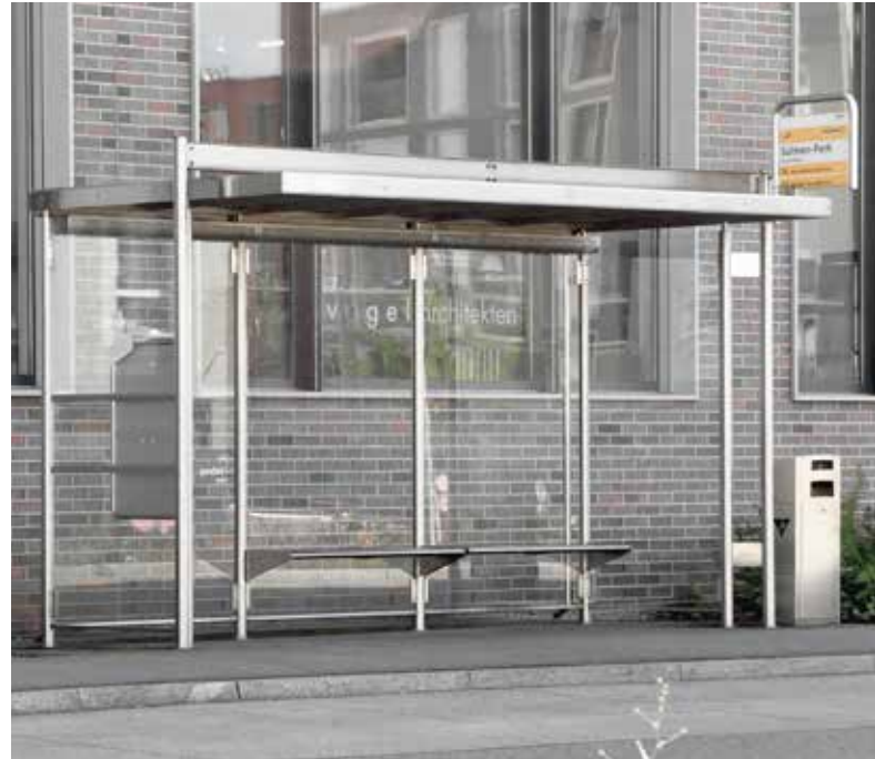
Shelter à Rheinfelden sur la ligne de bus n° 100, parois vitrées transparentes
