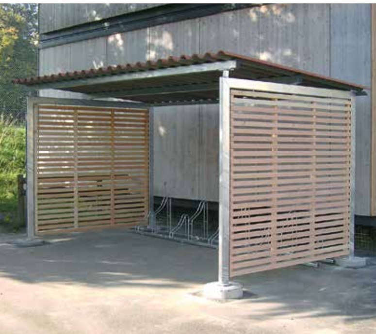
Des parois en lamelles de bois apportent protection et permettent de voir à travers. Toiture en plaques d'Eternit ondulées
