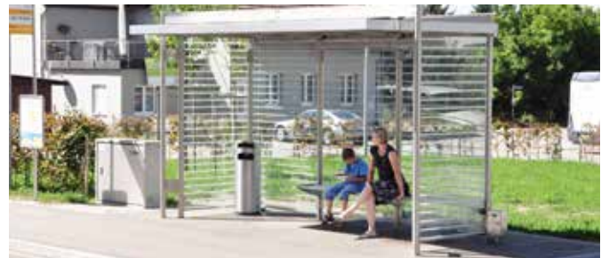
Möhlin, abri d'arrêt de bus sur la ligne 88 avec verre de protection des oiseaux
