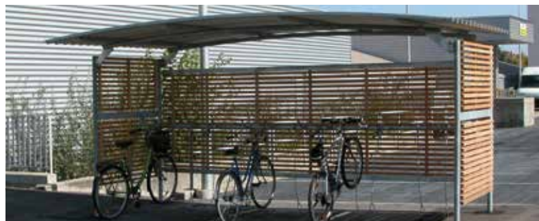
Parois en lamelles de bois, toiture en profilés de tôles d'acier
