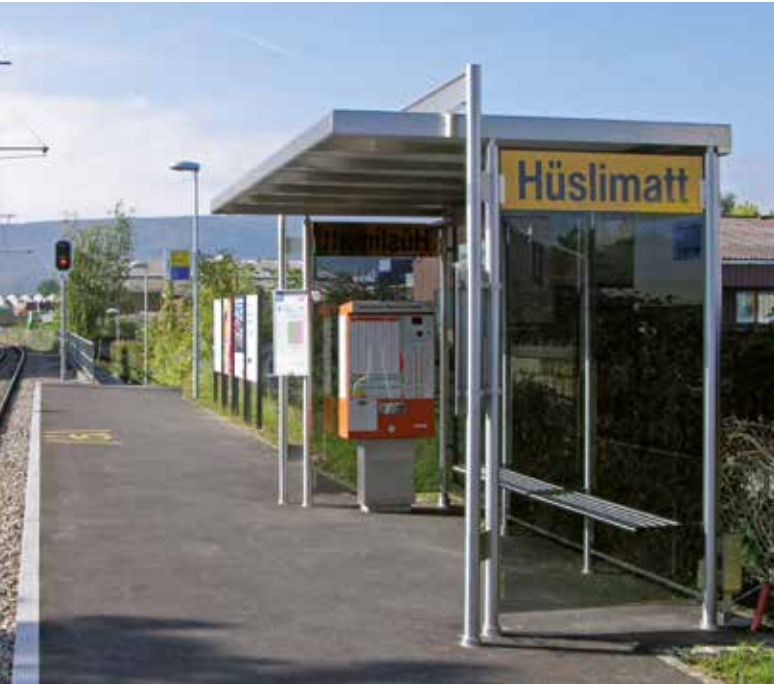
Shelter sur la ligne BLT n°10 à Oberwil (BL) équipé de verre fumé
