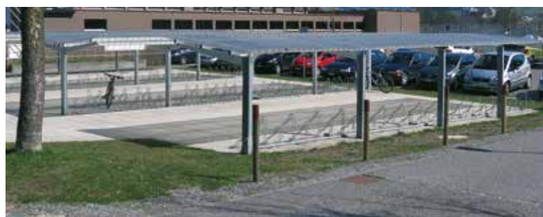
Installation de parking largement dimensionnée avec abris unilatéraux et bilatéraux
