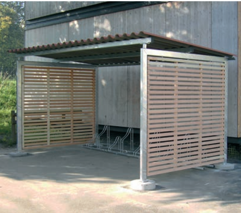
Wände aus Holzlamellen gewähren Schutz und Durchblicke. Dach aus Eternit-Wellplatten.
