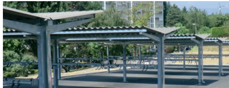
Die Dachkonstruktionen mit nach aussen verjüngten Auslegern wirken elegant
