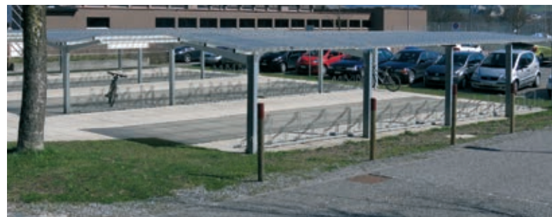
Grosszügige Parkieranlage mit doppel- und einseitigen Unterständen
