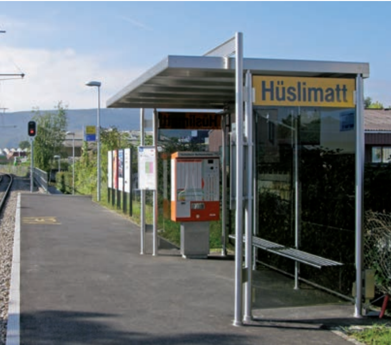
Shelter an der BLT-Linie Nr. 10 in Oberwil (BL) ausgestattet mit Rauchglas
