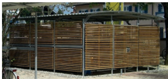
Umwandung und Türe aus Holzlamellen, Dach Stahl-Profilblech
