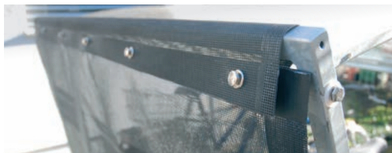
Detailansicht der Befestigung des Gittergewebes
