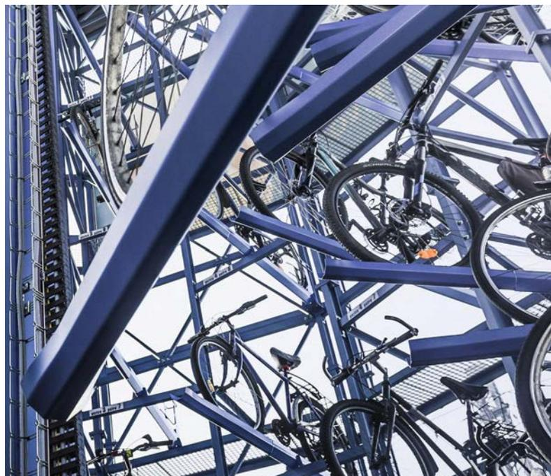
Auf einer Fläche von 55 Quadratmetern können mit dem Fahrradparkiersystem Bike Tower 118 Velos versorgt werden. Die Bedienung ist sehr einfach. Das Versorgen oder Abholen des Velos dauert 25 Sekunden, bezahlt werden kann mittels SMS oder direkt am Terminal. Eine Parkplatzreservation via Webseite ist zusätzlich möglich.
