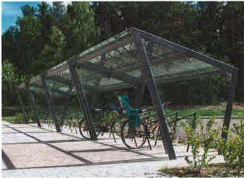
Die Fahrradüberdachung Edge mit Pultdach, integriert in eine Trapezkonstruktion, erhält durch die in die Laibung integrierten Dachträger ein schlankes Design. Die Rautenform setzt sich an den Seitenwänden aus Sicherheitsglas fort.
