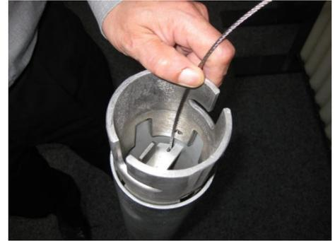
Introduisez le dispositif de blocage de corde à l'aide d'un double-mètre dans le dispositif de déclenchement dans la partie inférieure de la bitte d'amarrage. Maintenez-le avec le pouce et amenez l'extrémité de la bitte d'amarrage vers la douille de sol scellée dans le béton.
