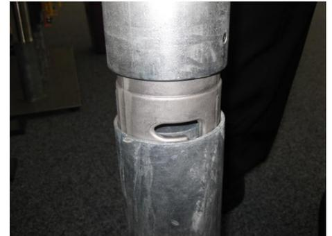
Introduisez le dispositif de blocage de corde dans l'évidement de la douille de sol et insérez la pièce moulée dans la douille de sol.
