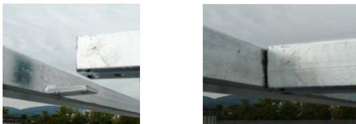
Monter la traverse supérieure en insérant la platine dans le tube cintré.
