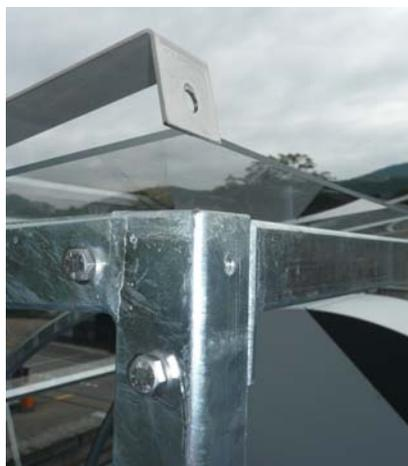
Les bandes en inox doivent être posées pour pouvoir fixer le profil en U au même moment.
