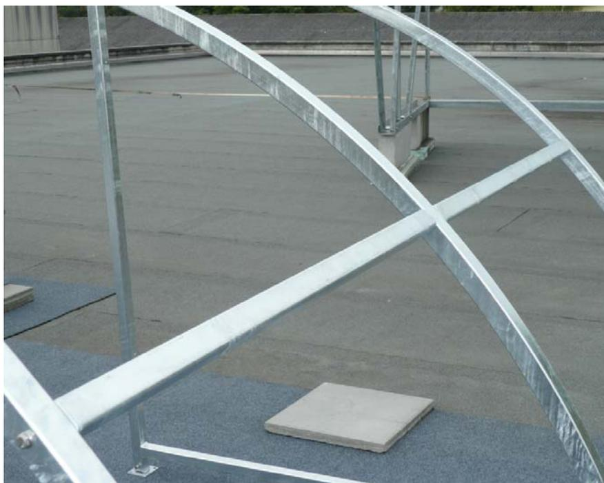
Fixer les traverses intermédiaires en plaçant l'ouverture vers l'intérieur de l'abri.
