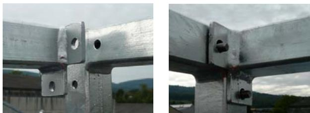
Fixer ensuite la traverse horizontale supérieure aux cadres latéraux. Insérer les vis de l'extérieur vers l'intérieur. Avant de serrer les vis, ajuster la traverse horizontale aux cadres.
