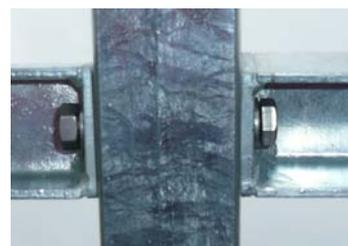
**Important:** Avant de serrer les vis, vérifier et ajuster si nécessaire les traverses pour qu'elles soient alignées aux trois tubes cintrés. Ainsi la paroi vitrée pourra épouser toute la structure.
