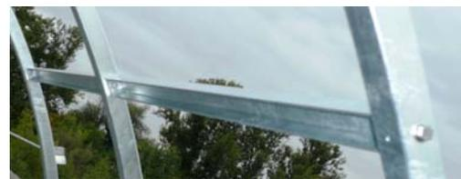
Insérer les vis de l'extérieur vers l'intérieur.
