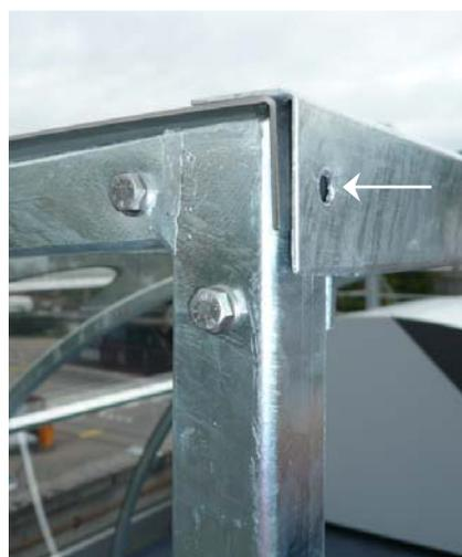
Faire descendre les bandes en inox et mettre le profil en U par dessus. Fixer le tout avec 3 vis (à travers le profil en U et la bande)
