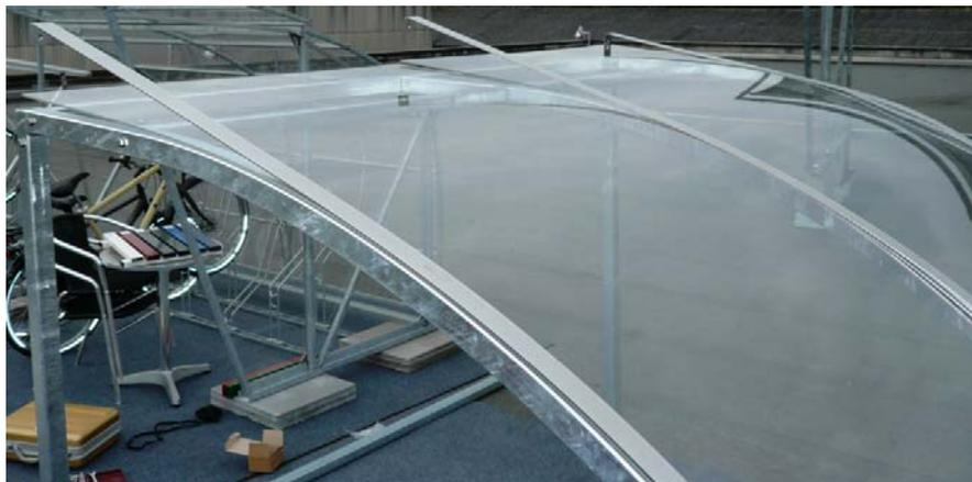
Poser les 3 bandes en inox sur la paroi vitrée pour que les tiges filetées entrent dans les trous des fers plats. Monter la rondelle et l'écrou sans les serrer.
