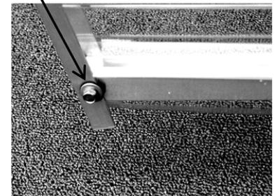
Poser les U-Profil 1006.2 en alu sur les plaques en polycarbonate et sur les tubes en alu et les fixer avec les Vis auto foreuses avec bague étanche 1110.
