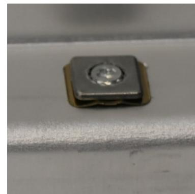
Introduisez les éléments de jonction dans les perforations et mettez-les en position finale en appuyant légèrement avec les doigts.
