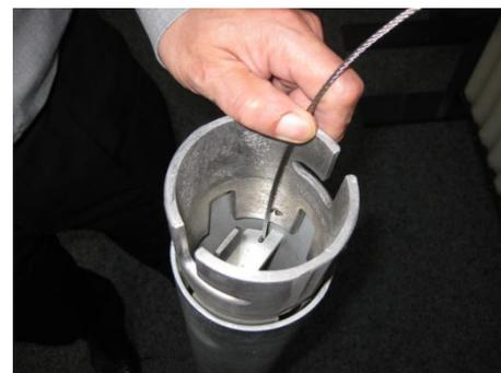
Führen Sie die Seilsicherung mit Hilfe eines Doppelmeters, in die Ausklinkung im unteren Teil des Pollers ein. Halten Sie diese mit dem Daumen fest und führen Sie nun das Pollerende zur einbetonierten Bodenhülse.
