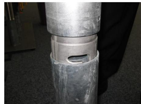
Führen Sie die Seilsicherung in die Aussparung der Bodenhülse ein und setzen Sie das Gussteil in die Bodenhülse ein.
