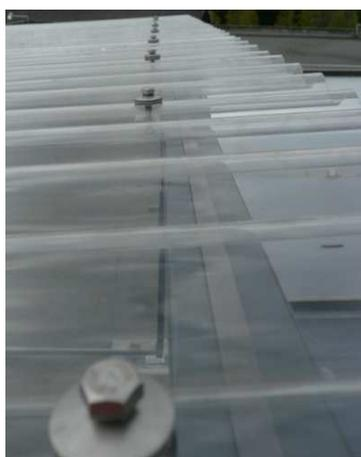
Nachdem das Dach ausgerichtet aufliegt, kann dieses nun angeschraubt werden. Hierfür werden Abkanthaken von unten her über die Dachträger geschoben. Die Lasche mit dem Loch für die Schraube befindet sich auf der hinteren Seite der Strebe.
