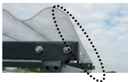
Die Dachelemente so auf die Dachträger legen, damit die Elemente gleichmässig auf den Dachträgern aufliegen und im nächsten Schritt mit den Abkanthaken befestigt werden können.
