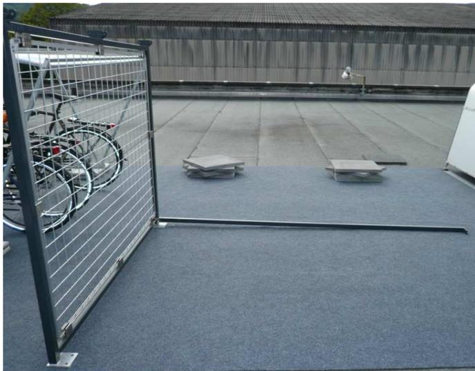
Nun können Sie zuerst den einen Seitenrahmen mit der Horizontalstrebe verbinden und festschrauben. Darauf achten, dass das Gefälle des Dachs nach hinten geht.
