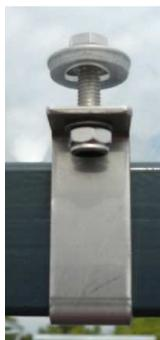
Die Schrauben so fest anziehen, dass die Dichtscheibe der Schraube auf der Seite ganz leicht herausgedrückt wird.
