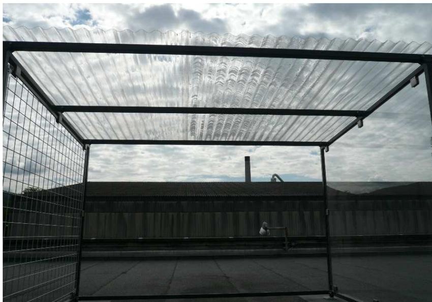
Bei der Ausrichtung darauf achten, dass die Dachelemente auf den Seiten bündig liegen.
