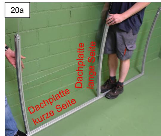
**Achtung: die Platte ist nicht quadratisch, die kurze Seite befindet sich hinten bei der Rückwand !**
