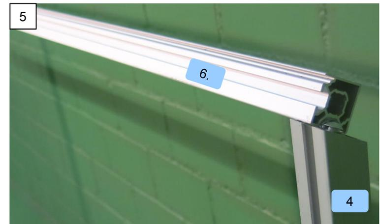
Führen Sie die Schiene des hinteren **Dachprofils Nr. 6** durch alle 3 Knöpfe der Rückwandwandprofile Nr. 3, 4 und 5.
