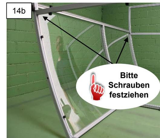
Führen Sie die Schiene des vorderen **Dach-Abschlussprofils Nr. 12** an die Rundbogen-Konstruktion. Fahren Sie beidseitig die Knöpfe in die Schienen der Rundprofile Nr. 9 ein. Schieben Sie das Profil nach hinten, bis die Dachplatten in die Aufnahmelasche eingeführt werden.
