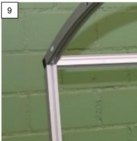
Das Rundprofil Nr. 9 wird mit der hinteren Stütze bündig gerichtet und festgeschraubt.
