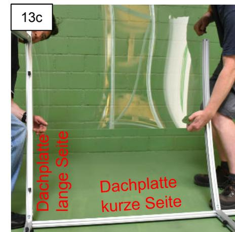
Schieben Sie eine Dachplatte in die obere Aufnahme der Rundprofile Nr. 9 und 11, bis zum Anschlag des hinteren Rückwand-Profiles ein. Eine Person fixiert dabei das mittlere Rundprofil Nr. 11 gegen das seitliche Verrutschen. Wiederholen Sie den Vorgang mit einer weiteren Dachplatte im zweiten Feld.
