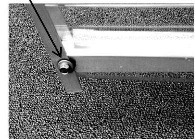
Das Alu U-Profil 1006.2 über die Profilglasscheibe und die Alurohre schieben und mit Fassadenschrauben 1110 befestigen
