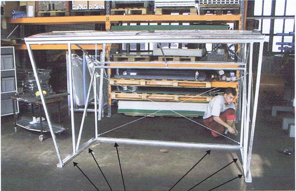
"Big roof" ausrichten, wenn nötig mit Unterlagsplatten unterlegen
