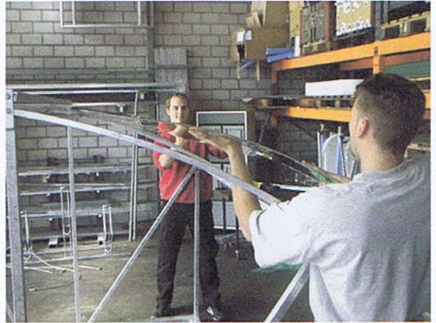
Die Scheibe einseitig in den Schlitz einlegen und durch aufbiegen der Scheibe in den vorderen Schlitz einfahren. Anschliessend die 4 Haltebügel pro Dachelement montieren.
