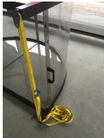
**19) Vertikaltraversen innen zusammen mit dem Abschluss Falzblech / Horizontalverbinder montieren. (Bögen mit Spannsset zusammenhalten)**
