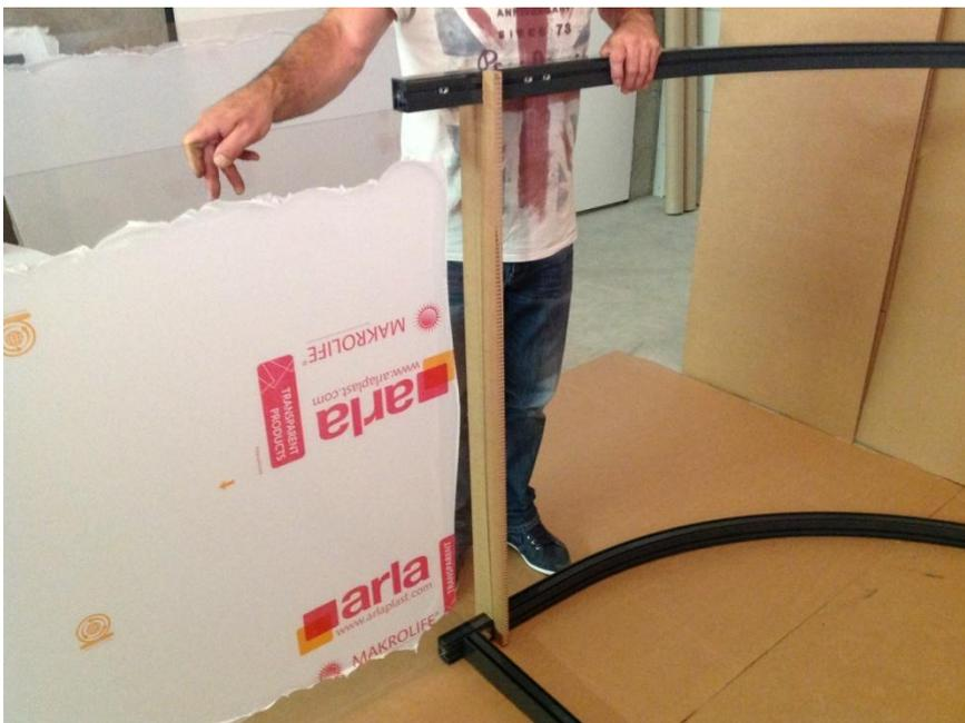
**Tipp:** Karton-Montagehilfe verschieben und Dachscheibe nachschieben. Karton-Montagehilfe dann entfernen...
