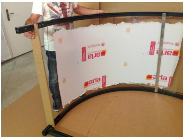
Dachscheibe Fix bis zum Querverbinder schieben und in der Nute platzieren.
