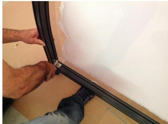
**22) Seitenscheiben ausrichten und Abdeckblech aussen mit Vertikaltraverse innen verschrauben**
