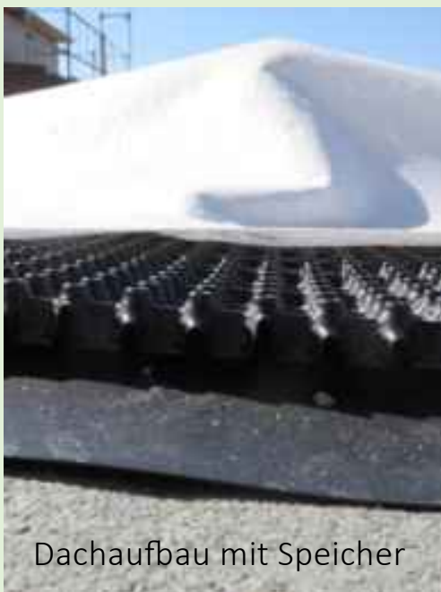
Vlies Speicher- und / oder Drainschicht Wurzelschutz
