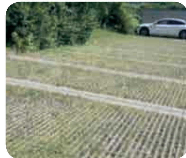
Abb 8: Parkplätze mit Rasenliner, Dietlikon
