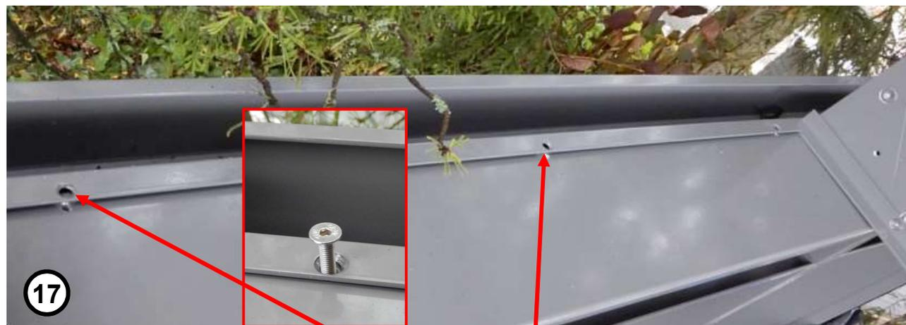
Inbus-Senkkopfschraube M5x12 mm
