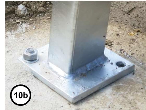
**10** Der Unterstand wird nun am exakt positioniert, die Löcher  $\varnothing$  10 mm gebohrt (M10) und der Unterstand mittels Dübeln/Schrauben (bauseits/nicht in der Lieferung enthalten) befestigt.
