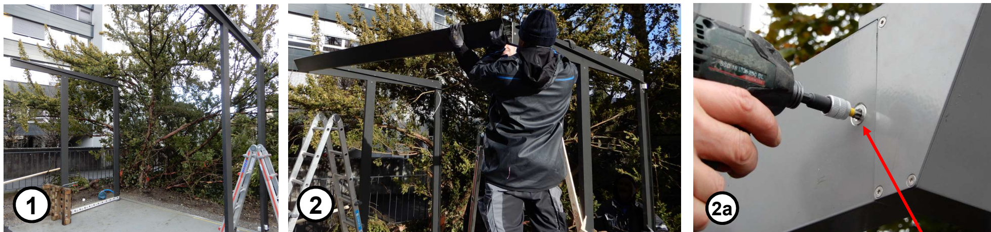
Senkkopfschraube Torx M8x12 mm Vis à tête fraisée Torx M8x12 mm
