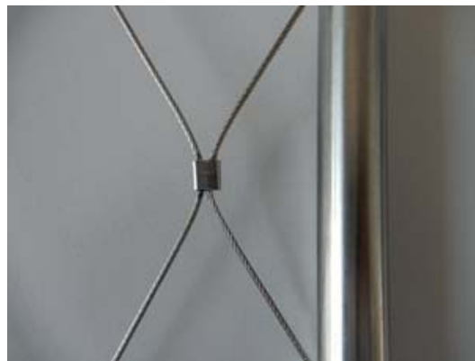
Raccordement du filet sur le côté avec des pinces à câble
