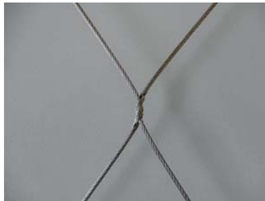
Transitions en treillis métallique tressé
