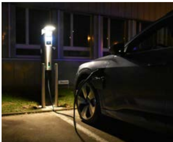
Station de recharge et borne d'éclairage avec déclenchement automatique de la lumière pour un ravitaillement facile et sûr.
