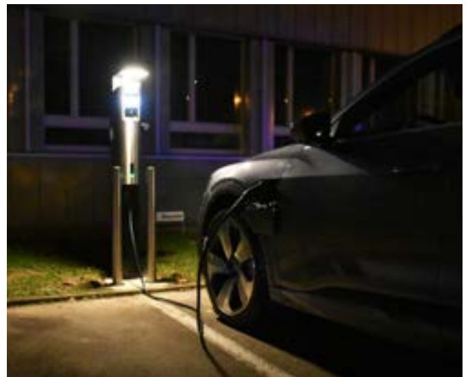
Ladestation und Beleuchtungspoller mit automatischer Lichteinschaltung für ein bequemes und sicheres Laden
